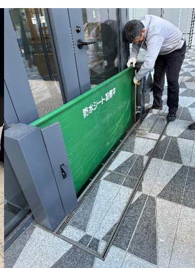
1階防水シート
