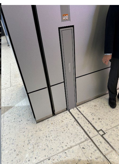
地下2階防水シート
