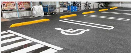
幅広の駐車区画の設置事例・ダブルラインの活用イメージ
