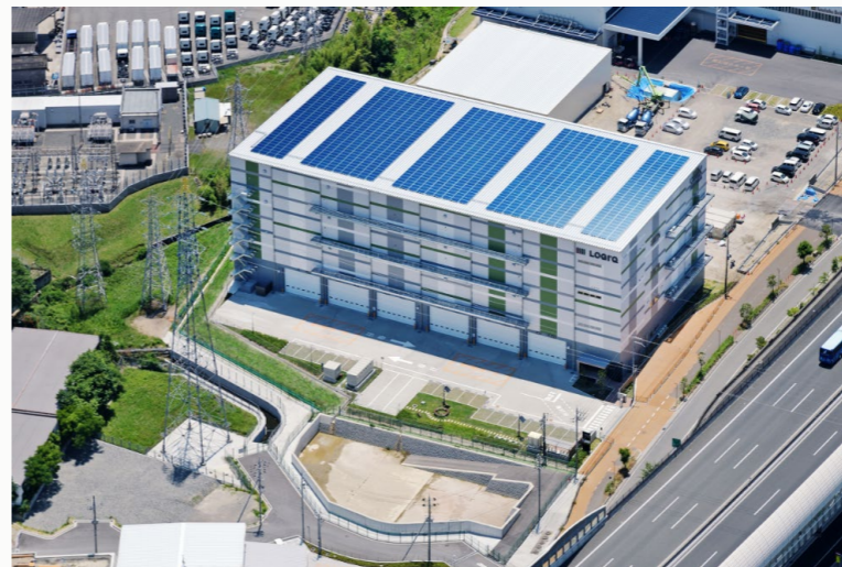
リエネLOGI'Q枚方 太陽光発電所 定格容量：0.3MW
