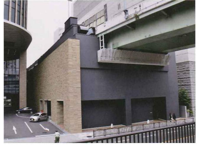
＜その他＞ 敷地内を通る阪神高速道路の下部建物の2階は前面道路より高さ5.5m、3階は9.5mに位置し、万一の浸水でも影響を受けないようになっています。同建物は一般建築物の約2倍の耐震性能を確保しており、非常用発電機や備蓄倉庫を設置しています。
