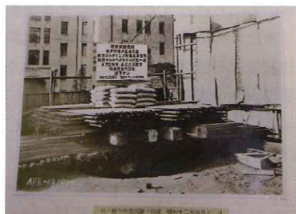
杭の耐力荷重試験の様子
