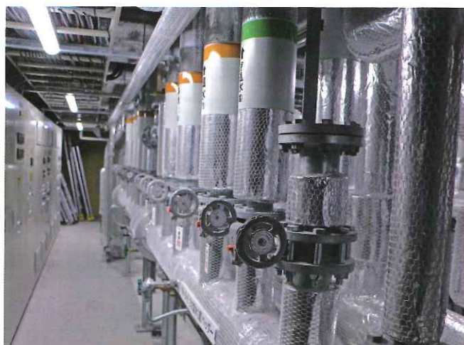
地下の設備室
