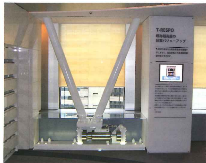
既存超高層ビルの制振対策 (新宿センタービルの例、大成建設(株)提供)
