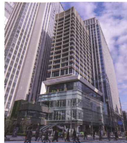
新ビル外観 (南側)
