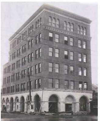
昭和6年に竣工した旧館
