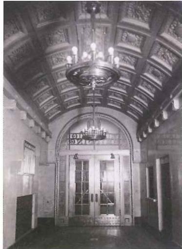
竣工時の1階エントランス
