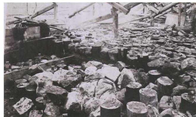
松杭打ちの状況
