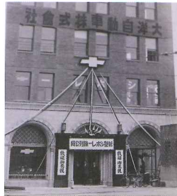
竣工当時の正面玄関
