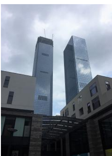
ビジネス塔 2棟同時建設
